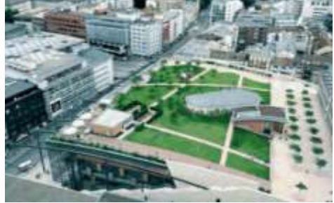
الشكل (5) يوضح حديقة سطح فندق Grange، لندن 3-4 سويسرا:
