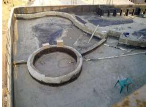
شكل (12) اعمال المباني
