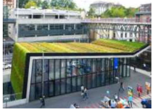
شكل (6) يوضح محطة مترو في لوزان، سويسرا
