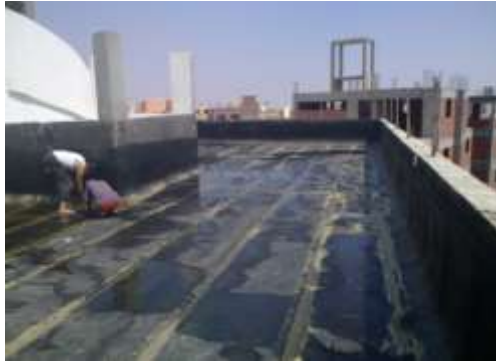
شكل (10) دراسة الحالة: مرحلة العزل Bitumen Membrane (عزل بالباشبوري) او polyethylene (المستخدم لعزل المسطحات المائية)
