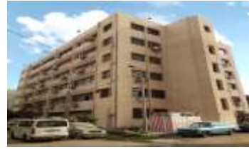
شكل رقم (3) المبنى محل الدراسة. المصدر : الباحث
